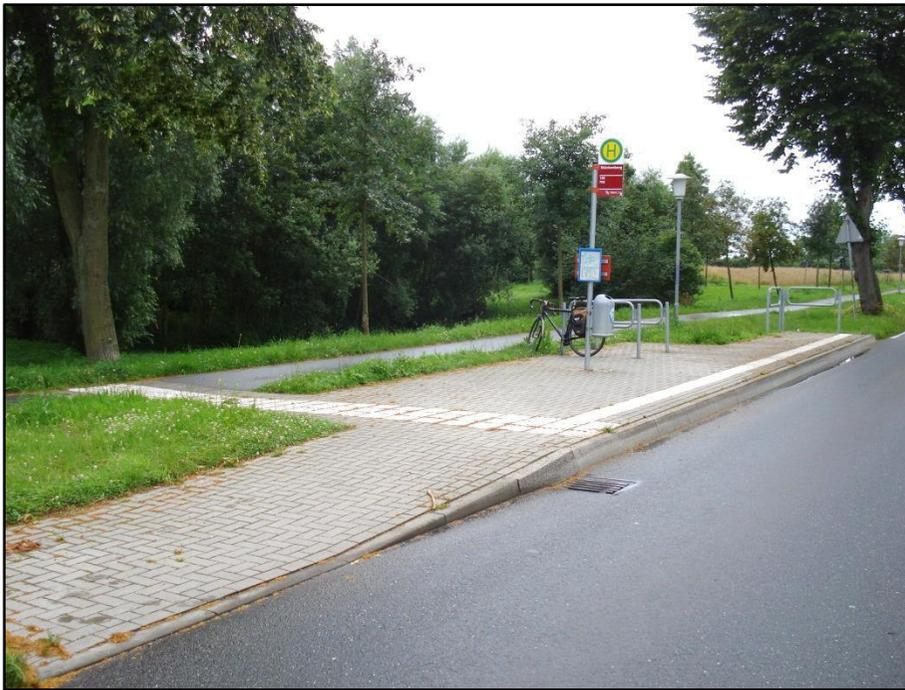
Abb. 18: Barrierefreie Haltestelle mit abgesenktem Bordstein zur Fahrbahnüberquerung, erhöhtem Bordstein im Haltebereich des Busses, Bodenindikatoren und geräumiger Wartefläche (in Heikendorf)
